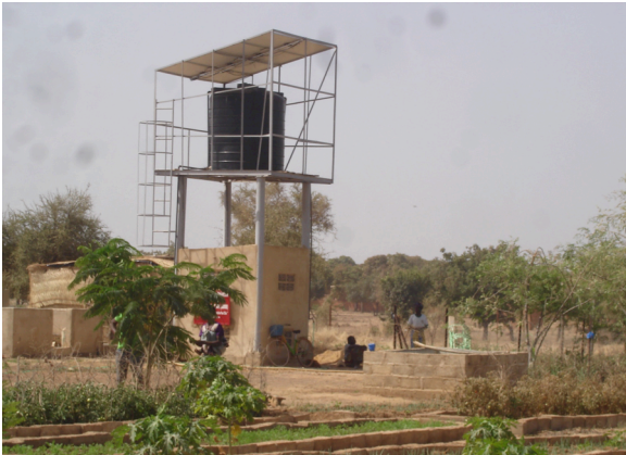
La pompa solare con serbatoio a Loumbila
